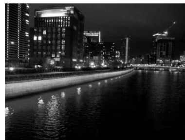
【ライトアップ照明施設整備(大阪府)】
