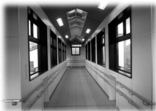
跨線橋内通路
