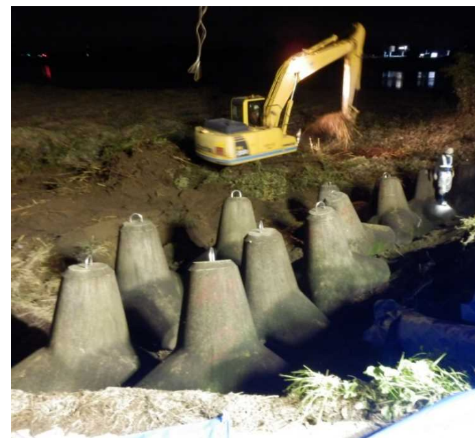
荒締切工(根固めブロック据付け)
