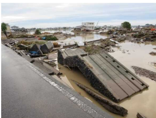
【決壊地点近傍】家屋等の流出状況(撮影日:9/11)
