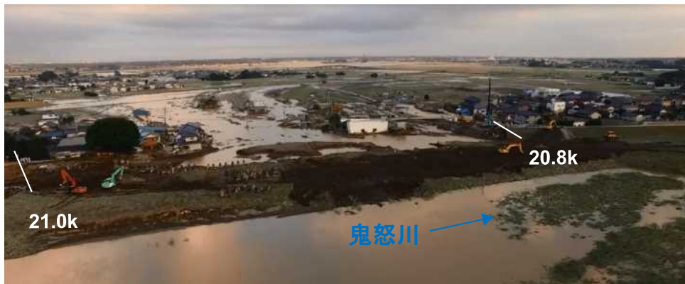
応急復旧状況(9/12)
