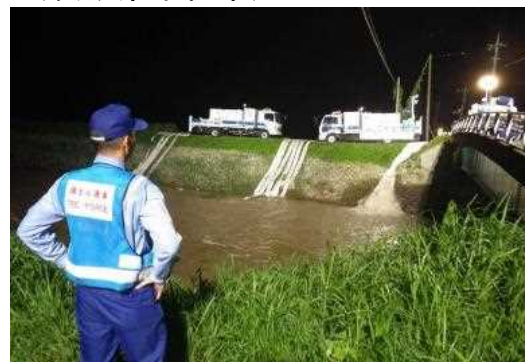
■24時間体制による緊急排水活動 (茨城県常総市)
