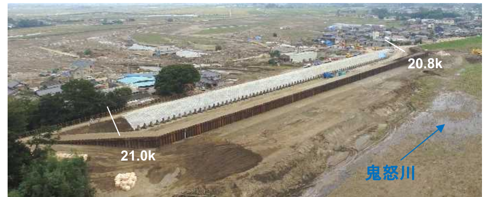
応急復旧状況(9/24)
