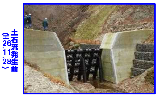
■田茂沢における土石流捕捉状況(写真:田茂沢第2砂防堰堤)
