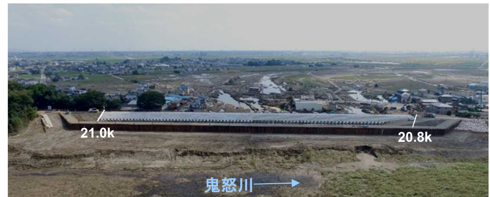
応急復旧完了後の状況(9/27)
