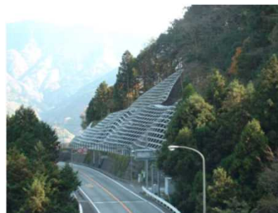
斜面崩壊防止対策
