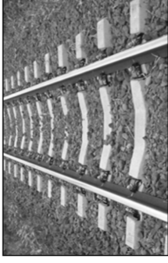
軌道のPCマクラギ化
