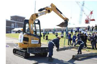
道路の通行阻害となる倒壊電柱を除去する訓練
