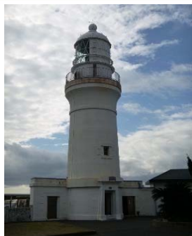
御前埼灯台 全景
