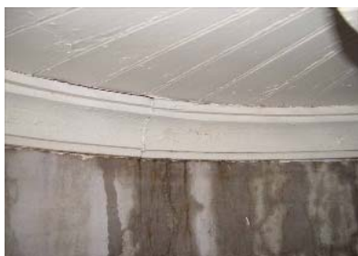
内部漏水状況
