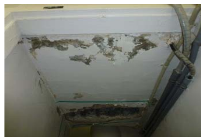
内部漏水状況
