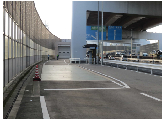
車両重量計設備の事例
