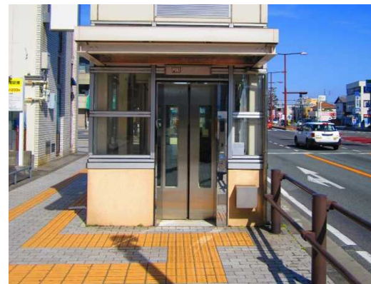
道路用昇降設備の事例
