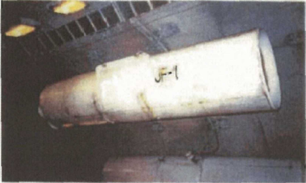
写真－１ 発錆、腐食状態のランク [B]
