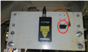
図9 光電センサ（トロコン位置検出）
