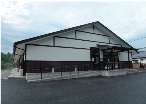
福島県相馬市の災害公営住宅。被災高齢者の孤独状態を防ぐため、団らんの場や食堂エリアなど、共助スペースを随所に設置している。
