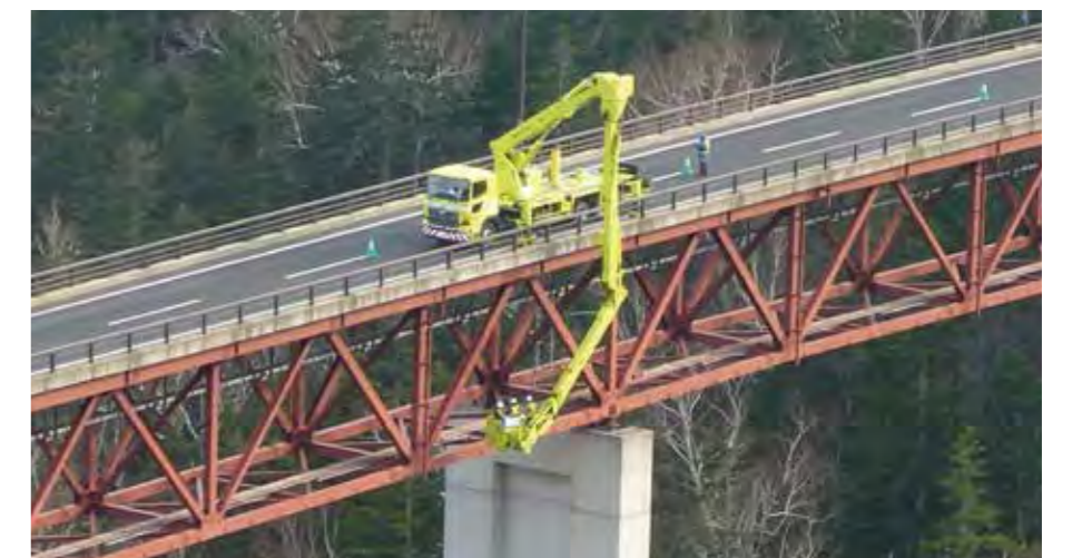
道路構造物の点検状況
