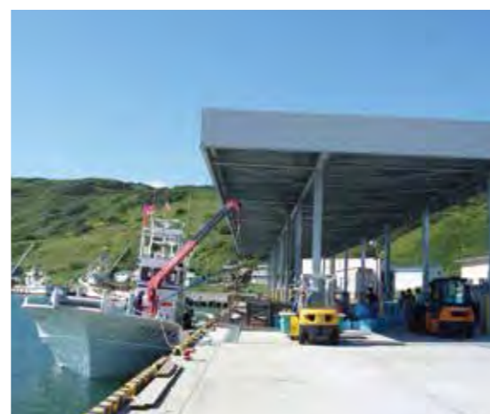
屋根付き岸壁
