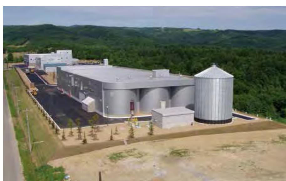
広域ごみ処理施設 メタン発酵槽 (中空知衛生管理組合リサイクルセンター)
