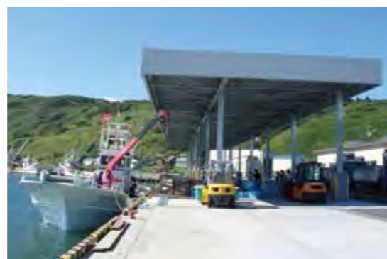
屋根付き岸壁
