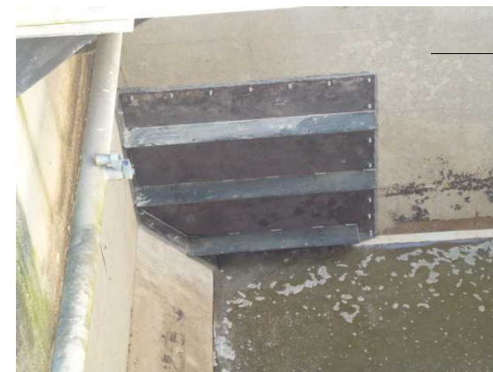
開口部を鋼板にて閉塞
