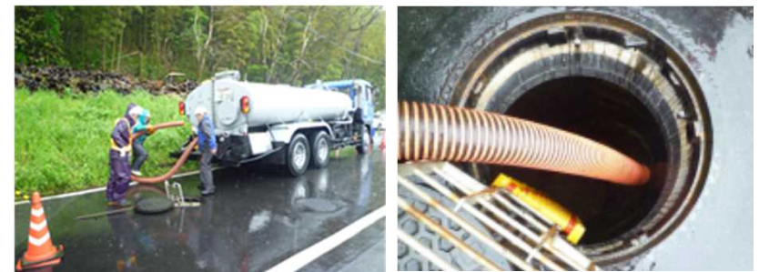
③熊本北部流域下水道のマンホールへし尿投入
