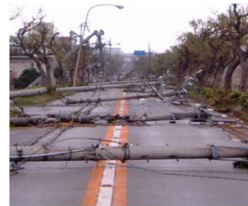
＜電柱の倒壊による道路閉塞の事例＞
