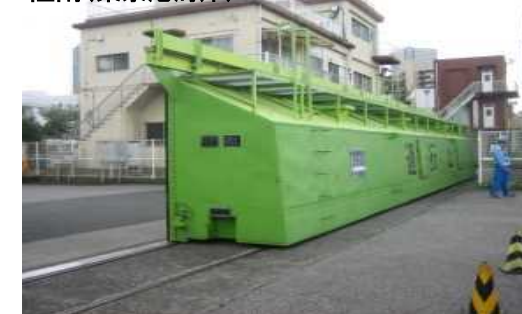
陸閘(東京港海岸)
