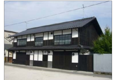
【広島県庄原市】長屋住宅を交流・展示施設として活用
