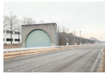
全長700mのトンネル。以前はバスを実際に燃やして排煙の研究も行っていましたが、現在はソフト面の実験が中心。
