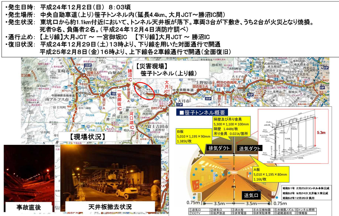
図2-1-21 笹子トンネル天井板落下事故の概要
