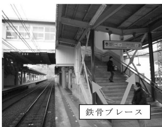
【橋上駅の補強】
