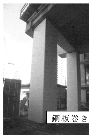
【高架橋の補強】
