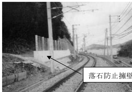
【落石防止擁壁の一例】
