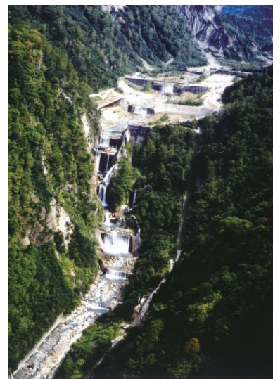
国の重要文化財にも指定されている白岩砂防堰堤。立山カルデラのシンボリック存在。
