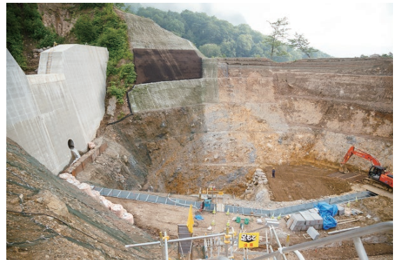
滝谷第1号砂防堰堤工事
