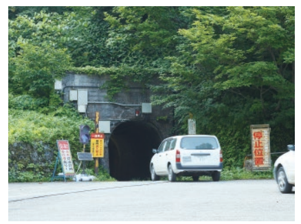
水谷出張所や各建設事業者の宿舎がある水谷平と現場をつなぐ道は白岩トンネルだけ。旧軌道線時代のまま使っているので車幅と同じくらい狭さ。
