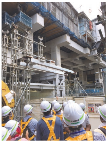
銀座線渋谷駅の改良工事現場
