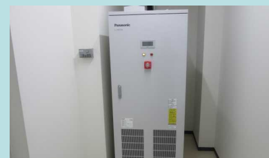
リチウムイオン電池：非常時は供給電力が停電しても、太陽光をエネルギー源としているので、日射があれば電源の確保はできるようになっている。
