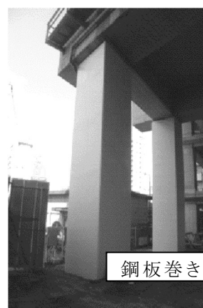
【高架橋の補強】
