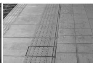
内方線付き点状ブロック
