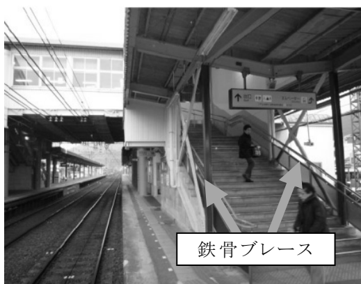
【橋上駅の補強】
