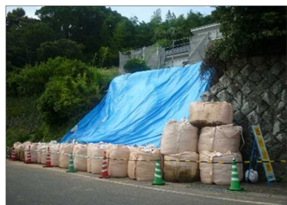
避難路を保全する土留工・排水工
