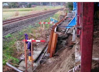
鉄道を保全する土留工
