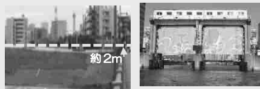
橋脚部周辺が2m低い堤防
