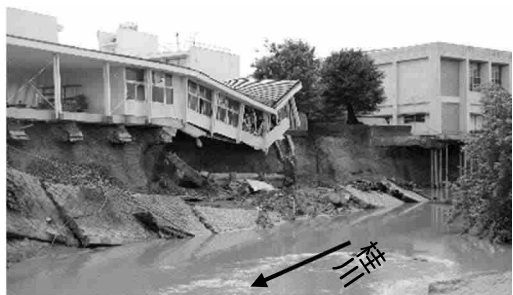
体育館や校舎の被災状況 福岡県朝倉市
