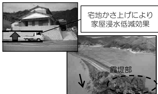
霞堤の存置と宅地かさ上げにより浸水被害を軽減した北川の事例（宮崎県）
