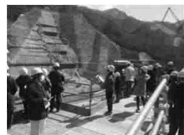
建設中ダムの現場見学 ハツ場ダム(群馬県)
