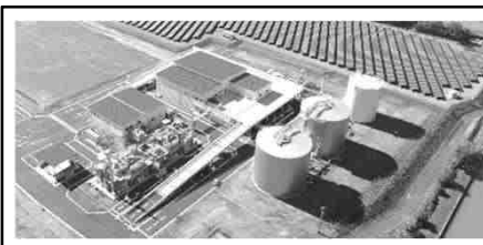
国内最大規模の地域バイオマス受入施設が平成29年10月に稼働開始(豊橋市)
