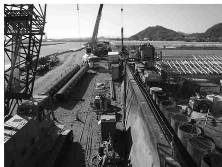
海岸堤防の耐震対策（高知県南国市）
