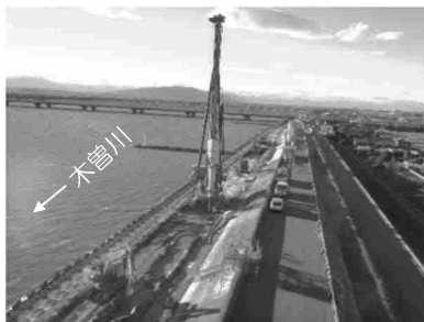
河川堤防における地震・津波対策 （三重県木曾岬町）
