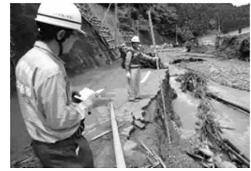
県道 509 号の被害状況調査
