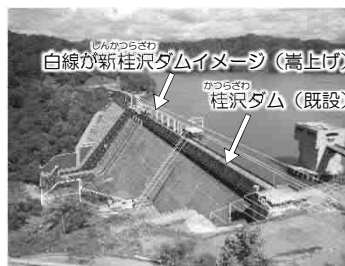
既設ダムのかさ上げによる発電増強の例（新桂沢ダム）
