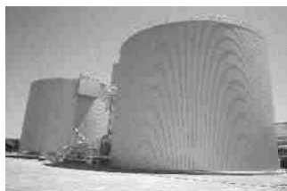
生ゴミやし尿等を集約して バイオガス発電を実施(豊橋市)
