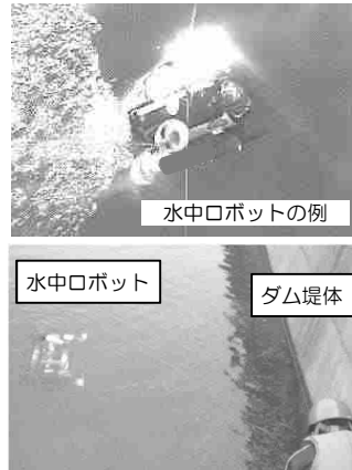
水中ロボットによる点検状況
