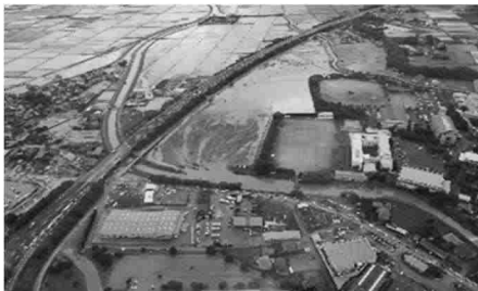
桂川沿川の浸水被害（福岡県朝倉市）
