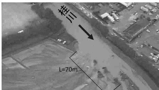
堤防決壊（桂川右岸） 福岡県朝倉市
