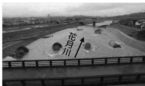
JR 久大本線の鉄道橋流出（花月川 2.7k 付近） 大分県日田市
