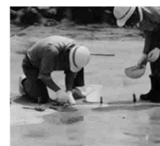
クラック補修状況（注入工）
