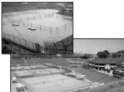
平常時はテニスコートとして利用される調整池の事例（神奈川県）
