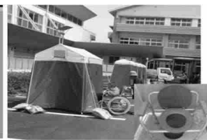
マンホールトイレの設置例 (熊本市)
