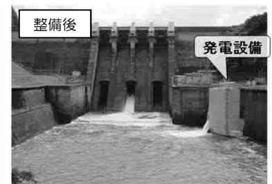
ダム管理用発電設備の設置例
