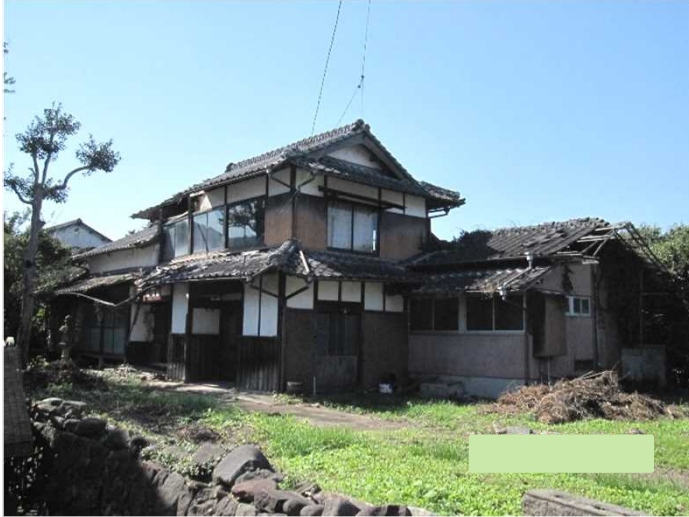
解体・除却前
