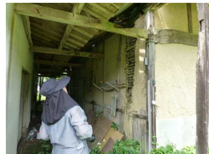
外壁の浮きの発生の有無やはりの変形や破損状況等について、建築士が町の担当職員と一緒に確認
