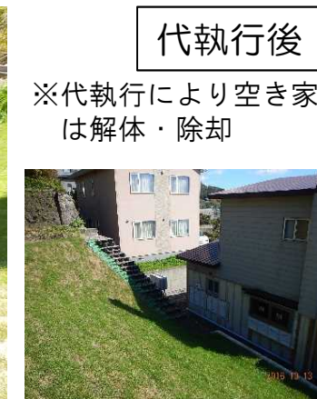
※崩落した擁壁を撤去し、新たに補強土擁壁を設置簡易な方法により法面を安定化
