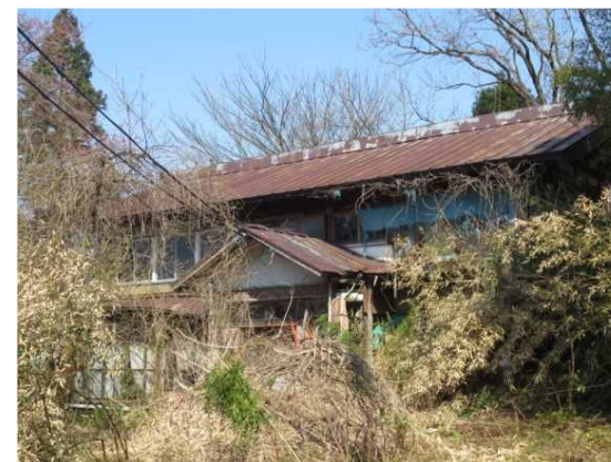
解体・ 除却前
