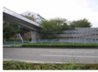
・長い急勾配スロープ(勾配1/10)
