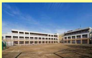
学校を改修して整備した事例
