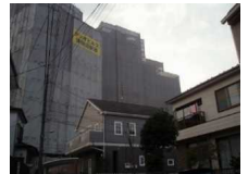
戸建て住宅地の高層マンション
