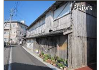
空き家の除却
