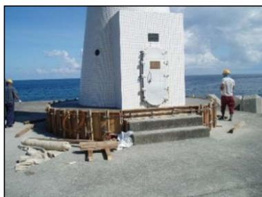
▲鉄筋コンクリートを用い建物の耐波浪強度の低下を予防する。
