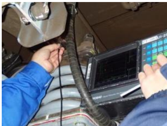
【超音波探傷状況】
