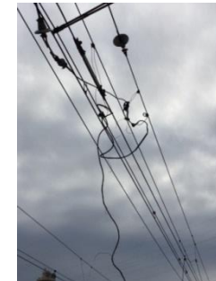
補助ちよう架線断線
