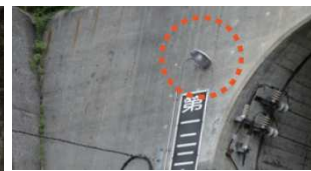
トンネル入り口の照明
