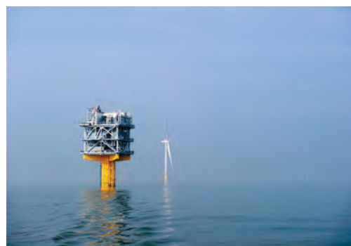
洋上風力変電施設 (London Array ウェブサイト)
