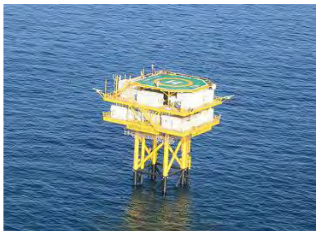
洋上風力発電所
