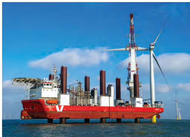
風車設置工事の様子
