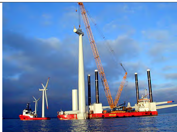
建設工事の風景 (Samso Havvind ウェブサイト)
