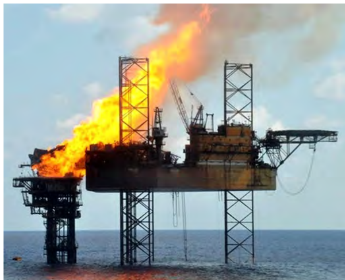
図 5.1.6 炎上するウェルヘッドプラットフォームと West Atlas (出典：wellintegrity.net ウェブサイト)
