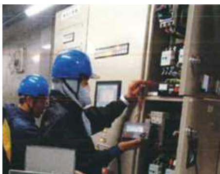
写真 5.3 絶縁抵抗測定
