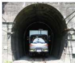
トンネラスによるトンネル内部の撮影
