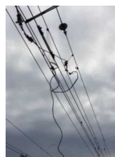
補助ちよう架線断線
