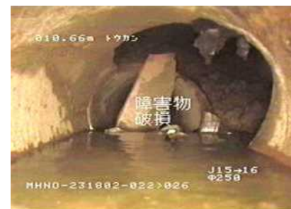
破損した下水道管
