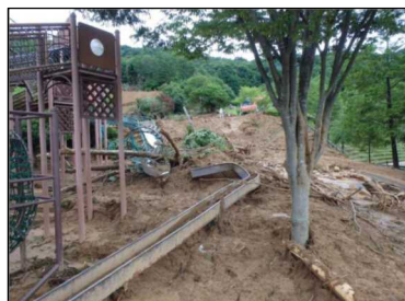
公園施設被災(広島県東広島市)
