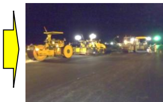
(老朽化した滑走路舗装の改良)
