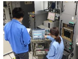
(航空保安施設点検実施状況)
