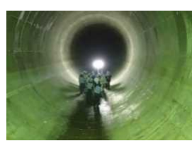
雨水貯留管の整備
