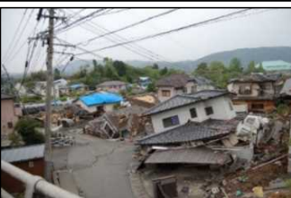
地震による被災状況 (熊本県益城町)
