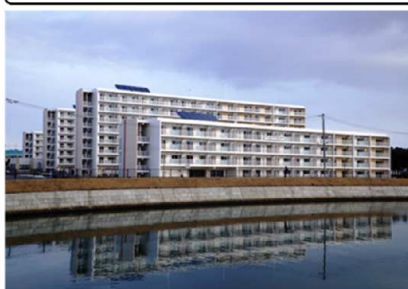
宮城県多賀城市・274戸(共同住宅)
