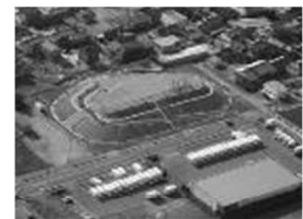
商業施設跡地等を活用した津波時の一時避難場所の整備（静岡県袋井市）
