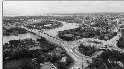
無償資金協力「新タケタ橋（ドーボン橋）建設計画」（ミャンマー）
