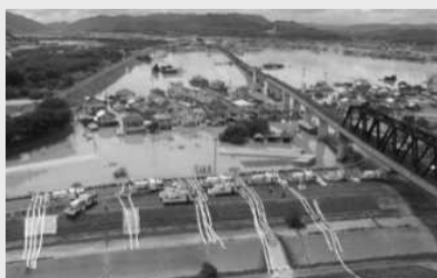
排水ポンプ車による排水状況 くらしきしまびちょう 【岡山県倉敷市真備町】
