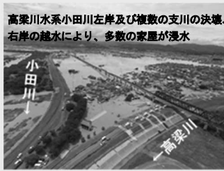
小田川における浸水状況 (平成30年7月豪雨)
