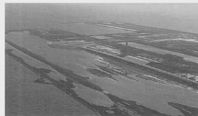
関西国際空港の被災状況 (台風第21号)
