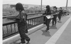
高校生による橋梁の日常点検
