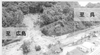
広島県道路・JR呉線の被災状況 (平成30年7月豪雨)
