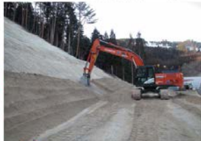
マシンコントロールによる丁張りレス施工
