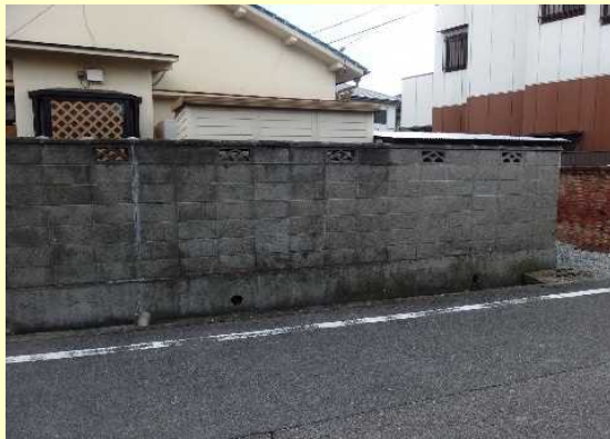
ブロック塀等の除却等を実施
