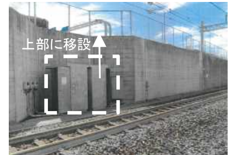
対策例 : 電気設備の移設
