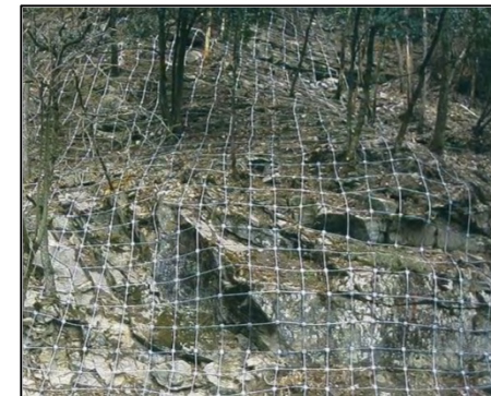
ロープネット工
