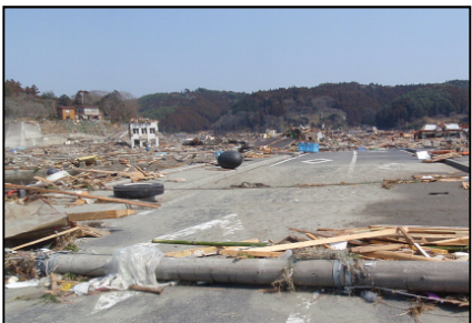
暴風、地震発生時の電柱倒壊による道路閉塞
