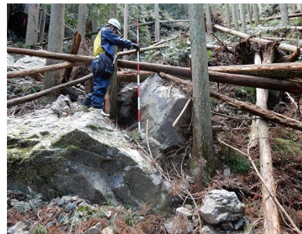
法面の岩塊状況
