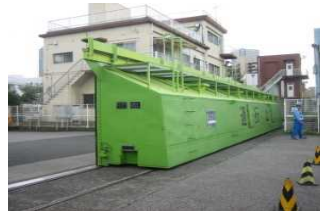
陸閘(東京港海岸)
