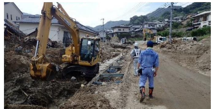
市街地の土砂等の撤去作業を支援
