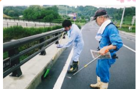
予防保全として排水柵 付近を清掃している様子
