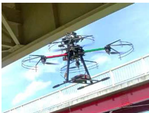
ドローンにより損傷写真を撮影
