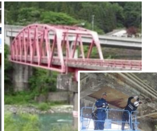
市町村が管理する橋梁の直轄による診断
