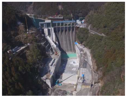
ダム改造工事実施状況(H31.2)
